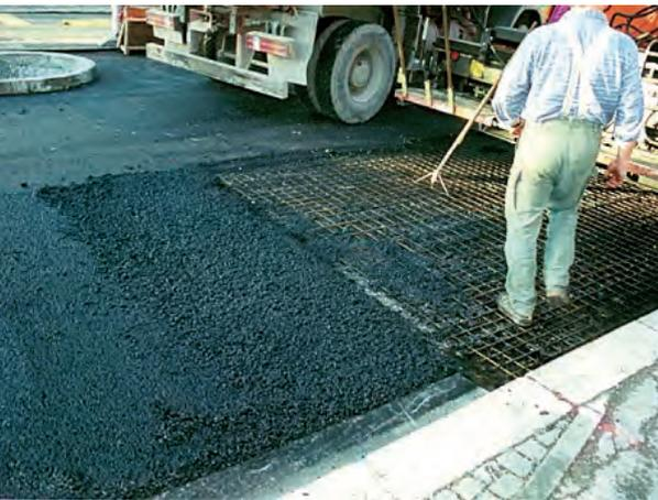
08 | REFLEX: Stahlbewehrung in Binderschicht
