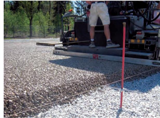
14 | Einbau einer hohlräumreichen kunststoffgebundenen Tragschicht (Terra Elast)
