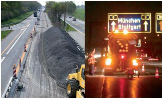
BAB A8 Deckschicht des Überholstreifens abgefräst
