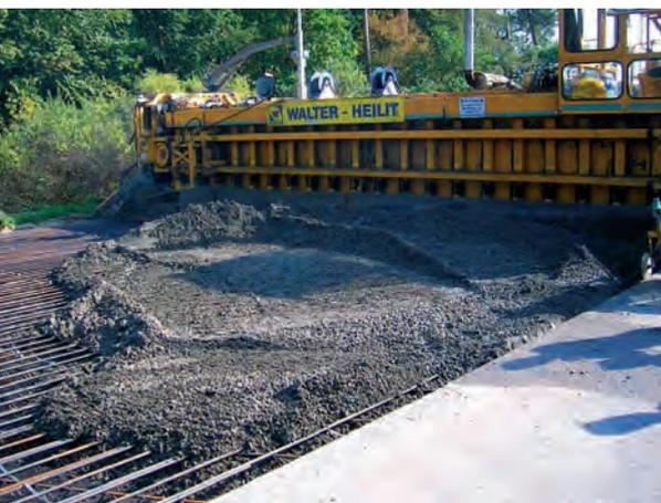
10 | Betondecke mit durchgehender Bewehrung, A5 bei Darmstadt, 2004; Einbau des Unterbetons (20 cm von 24 cm)
