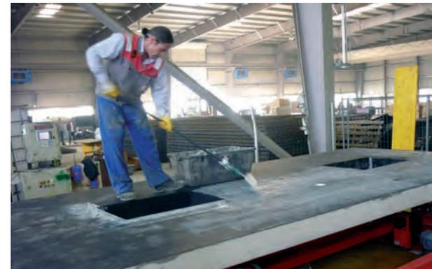
06 | Beschichtung wird auf Gleistragplatte aufgebracht
