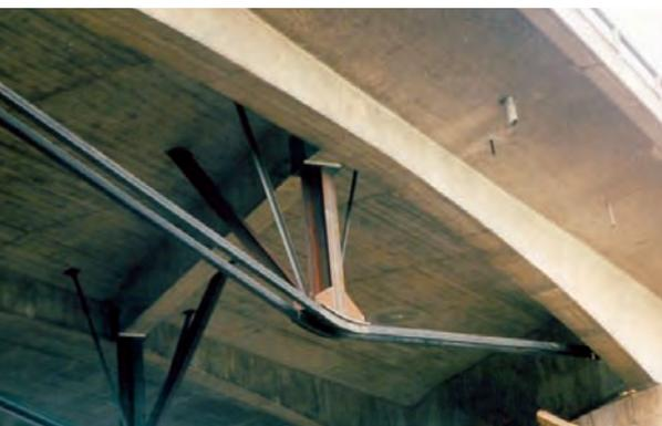
02 | Unterspannungskonstruktion
