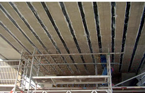
03 | A4.Ü01 – Lamellenverstärkung an der Tragwerksuntersicht im Feld BC
