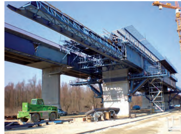
02 | Vorschubrüstung auf der nördlichen Vorlandbrücke
