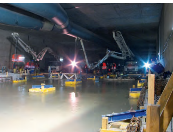
07 | Betonage eines Masse-Troges
