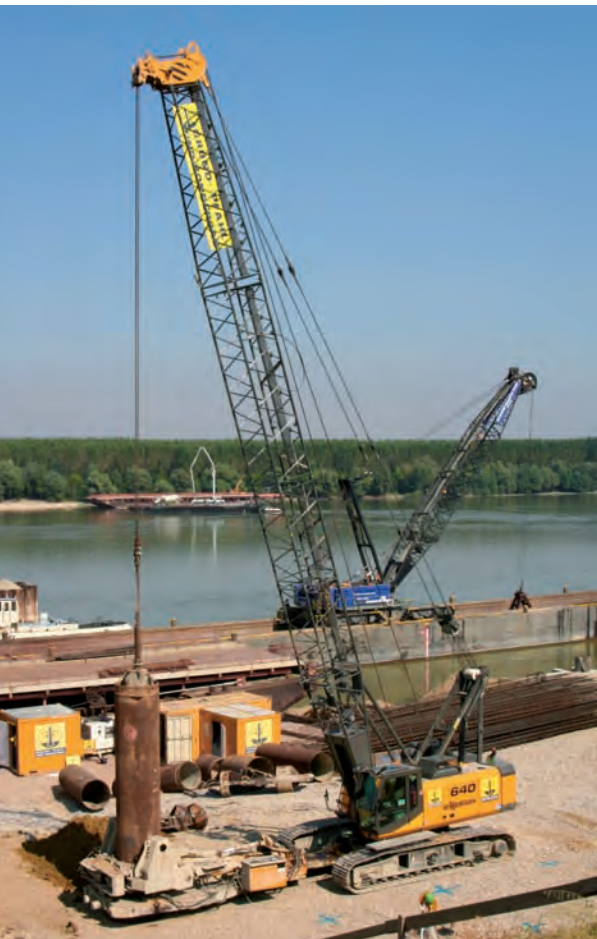
04 | Herstellung von Bohrpfählen
