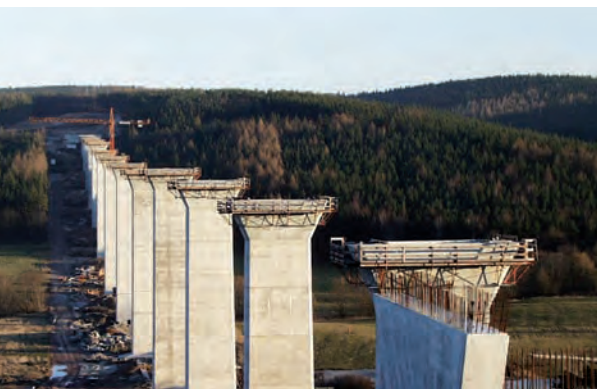
02 | Pfeileransicht von Westen
