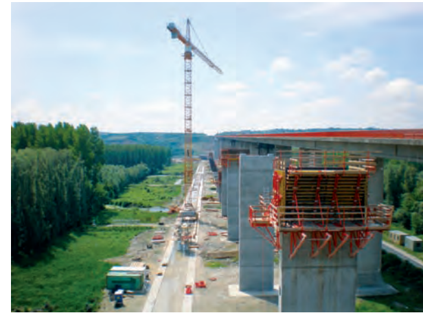
06 | Pfeilererrichtung mit Kletterschalung
