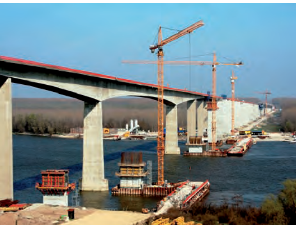
01 | Die alte Beska-Brücke während der Errichtung der neuen Flusspfeiler
