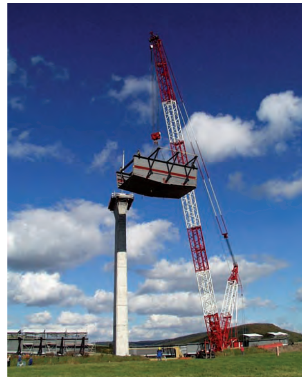
05 | Einheben Stützenschuss
