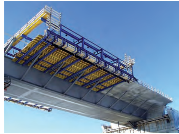
07 | Schalwagen und Fahrbahnplatte
