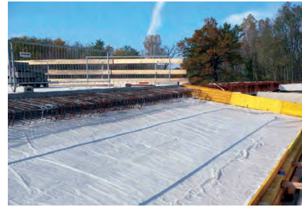
07 | Widerlagerhinterfüllung der Marktwasserbrücke, Niederösterreich
