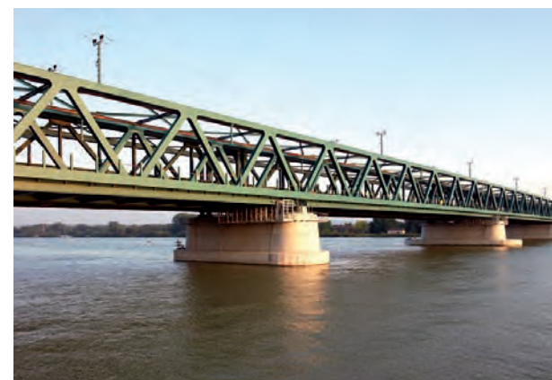
06 | Donaubrücke Tulln, Niederösterreich
