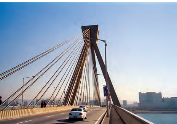
01 | Olympic Grand Bridge, Südkorea
