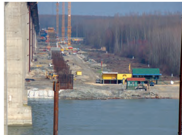
03 | Pfeilerherstellung Beska-Bridge, Serbien
