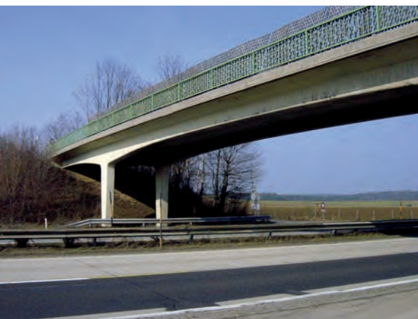
01 | S 101 Überführung Reibersdorf, Oberösterreich
