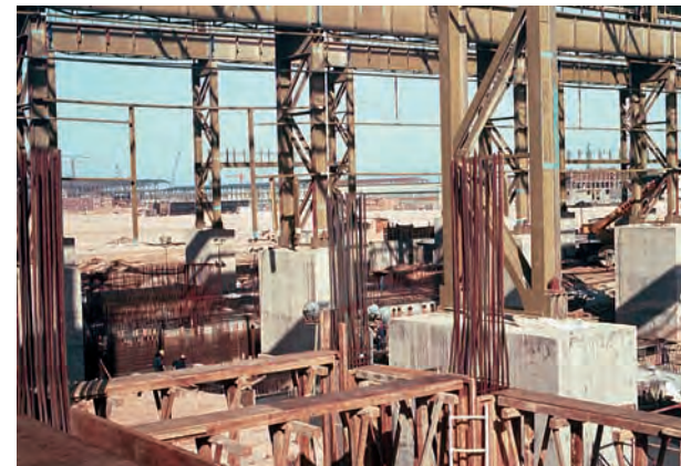
04 | Kaltwalzwerk in Misurata, Lybien
