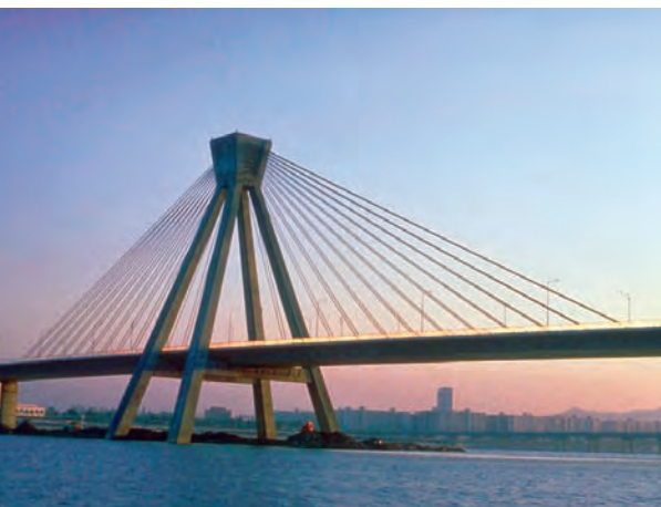
06 | Olympic Grand Bridge, Südkorea
