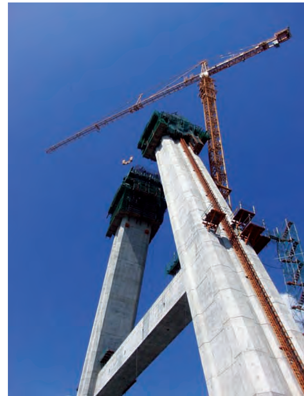
08 | Pylonherstellung Kao Ping Hsi Bridge, Taiwan R.O.C.
