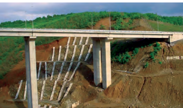
02 | Sanierung Rutschung T1, Griechenland
