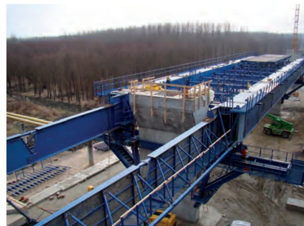
04 | Vorschubrüstung Beska-Bridge, Serbien
