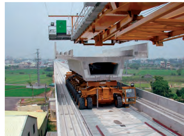
09 | Versetzen der Fertigteilbrücken, High-Speed-Railway, Taiwan R.O.C.
