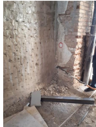
Verpressung Wandscheibe im EG des AD-Trakts
