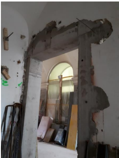
Einbau Stahlbetonrahmen
