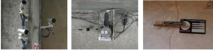
Messung von Verschiebungen und Rissweiten
