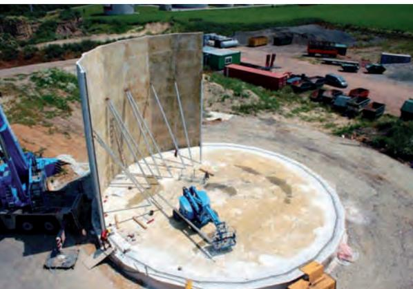
03 | Biogasbehälter in Fertigteilbauweise
