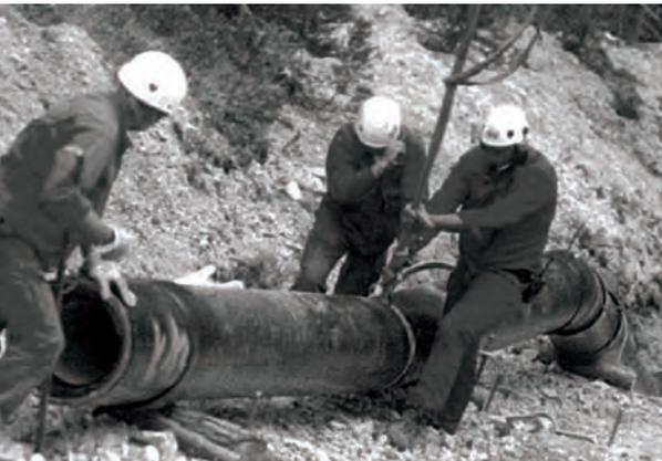
01 | Verlegung einer von der TRM AG produzierten Druckrohrleitung aus duktilem Gusseisen
