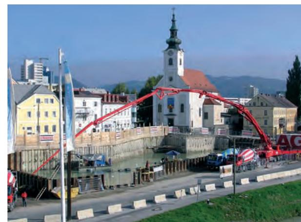
04 | Unterwasserbetonsohle beim Betonieren
