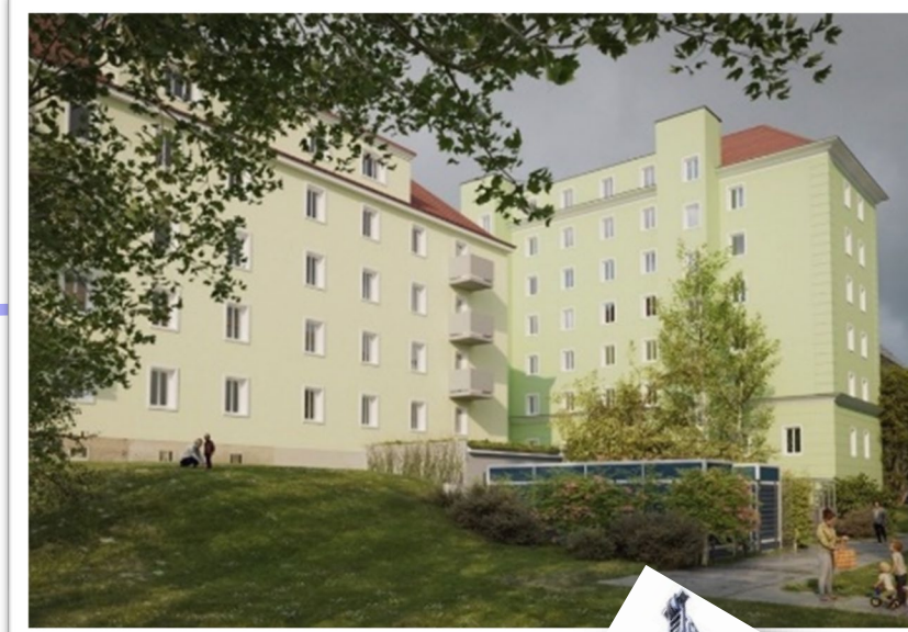
nach Sanierung & Dekarbonisierung
